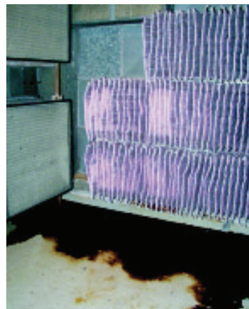
Rensidan efter filtret i ett tilluftssystem
